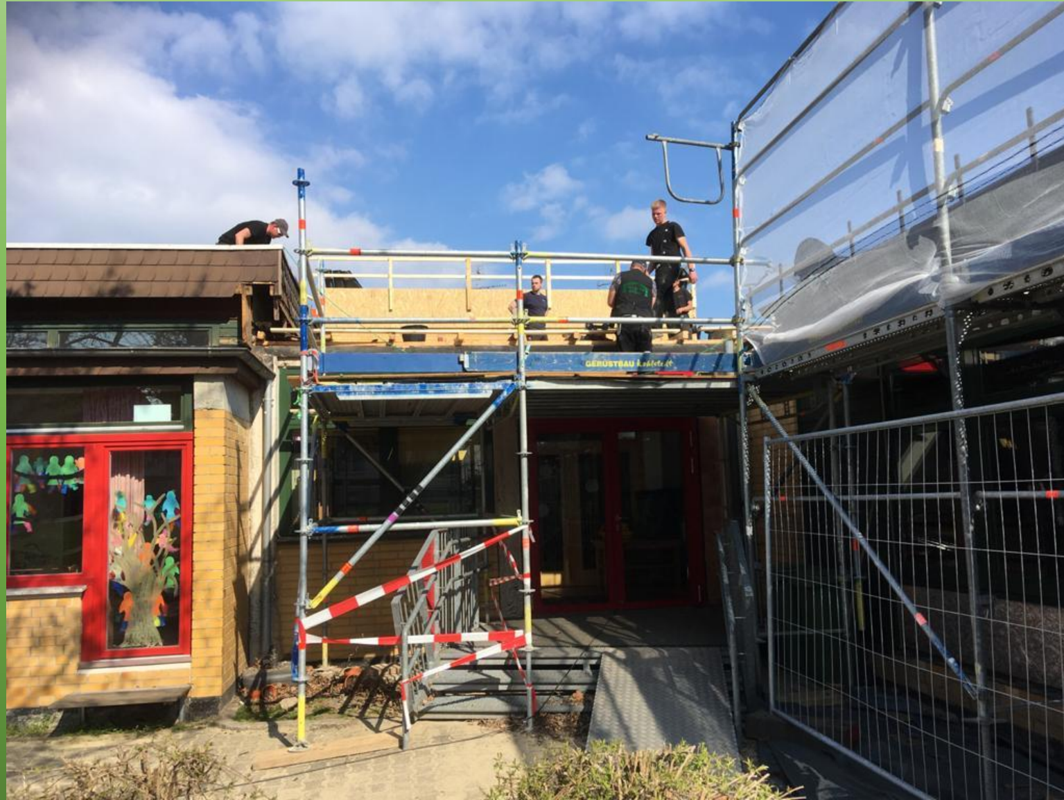
Die Dachsanierung und das Setzen der Dachluken.
