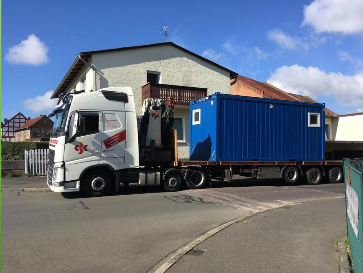
Der vorübergehende „Waschraum“ kommt.
