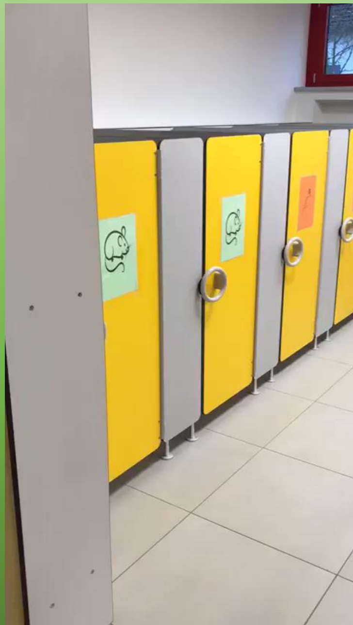
Der frisch sanierte Waschraum - 1. KW 2021
