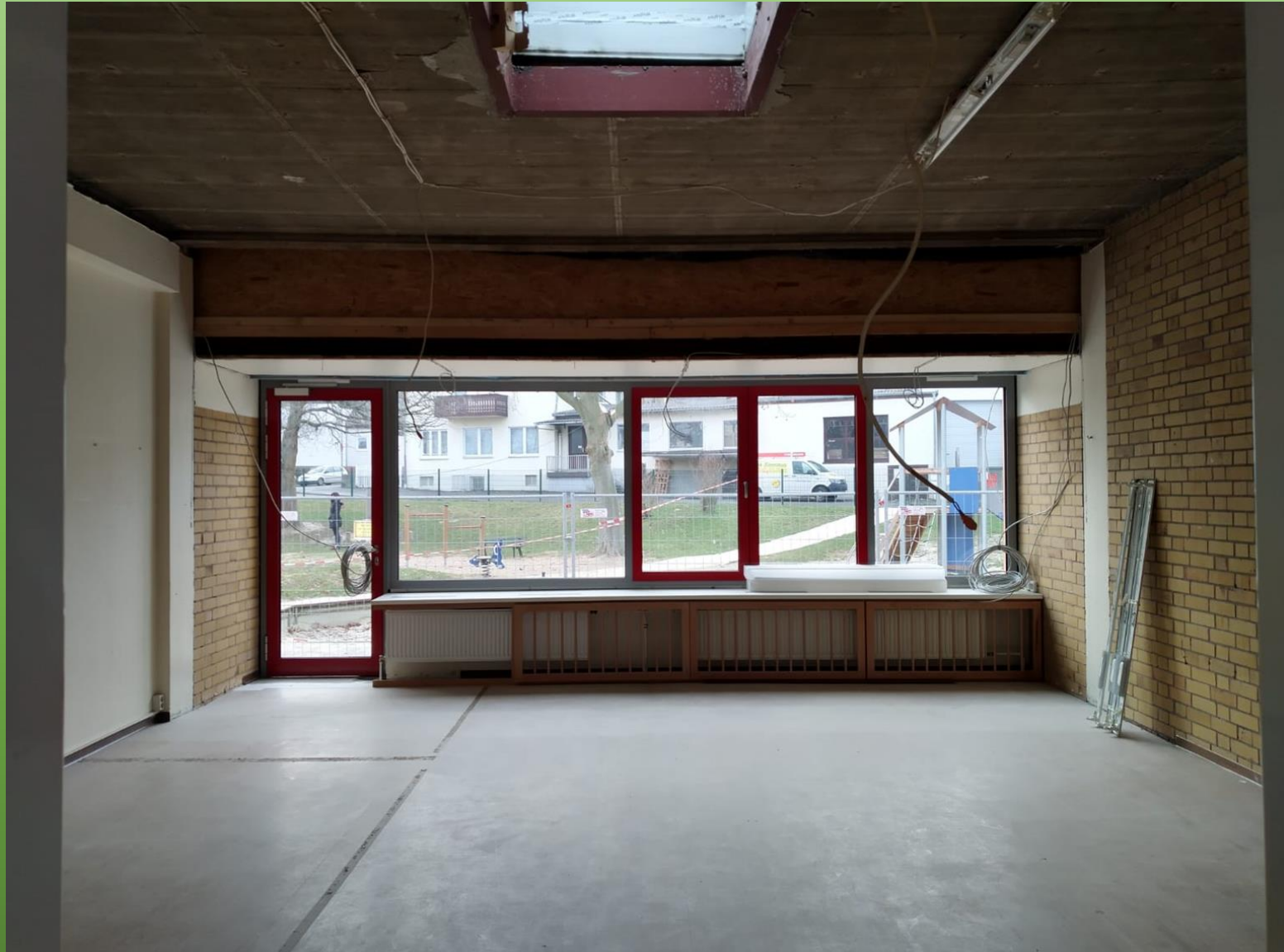
Die neuen Fenster wurden bereits eingebaut.
