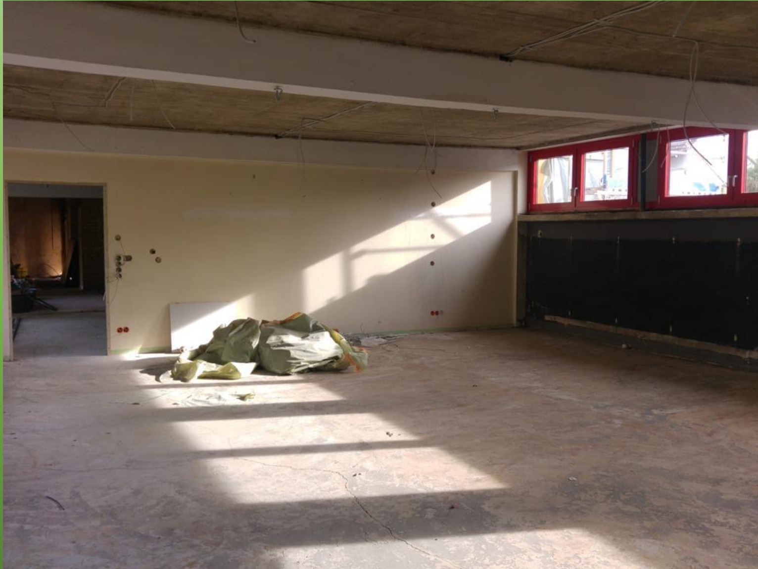
Blick vom Bewegungsraum Richtung Eingangsbereich
