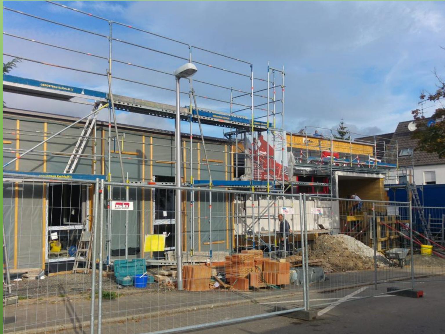
Die Erweiterung zur Krausgasse
