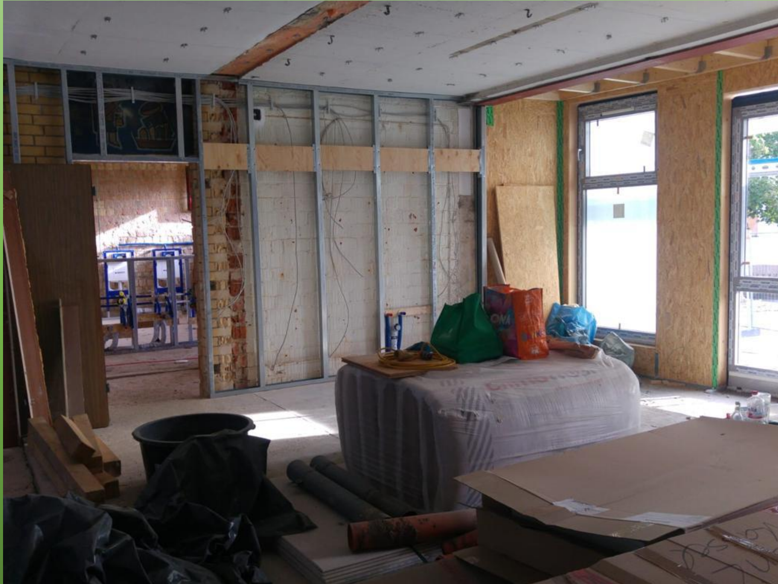
Neu entstehender Gruppenraum mit Blick in den Waschraum.
