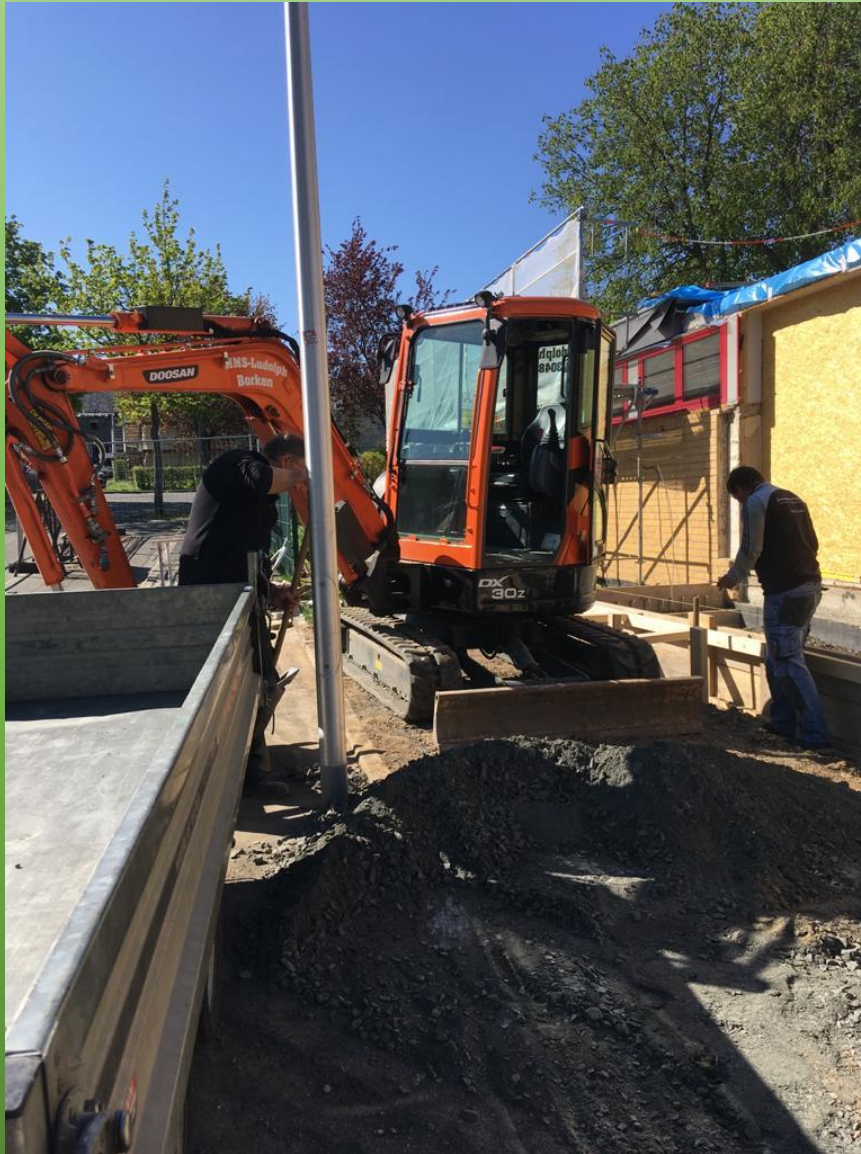
Hier entsteht die Erweiterung zweier Räume.
