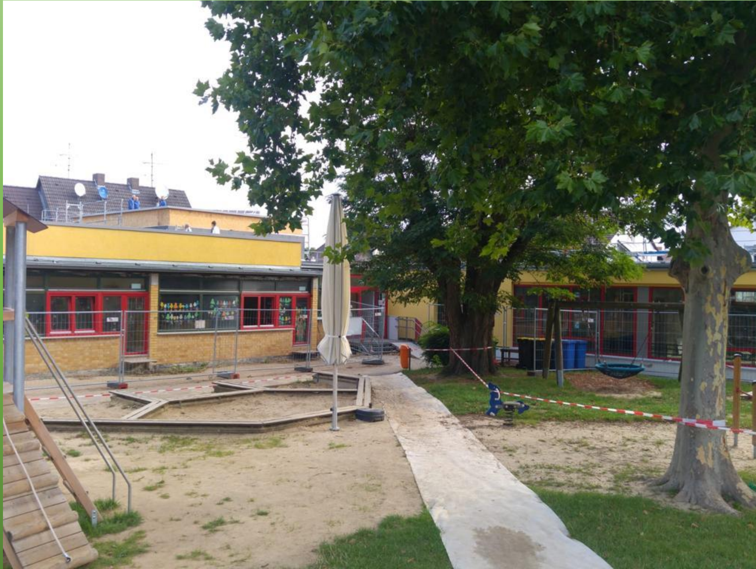
Eingangsbereich während der Bauphase vor dem Haupteingang
